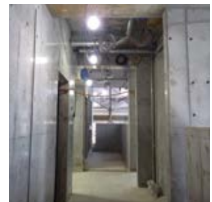
施工現場でのLED照明
