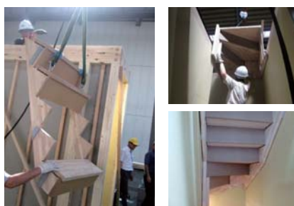
プレカット階段の採用にあたってのモックアップ検証状況
