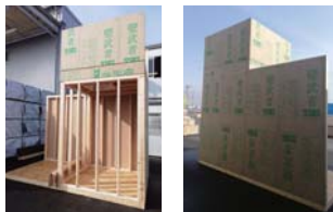
パーティクルボードの採用にあたってのモックアップ検証状況
