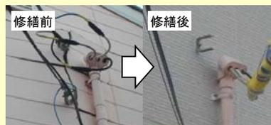
▲電柱倒壊により破損した外壁の張替え
