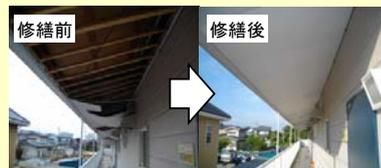
▲2階通路の崩落した天井パネルの張替え
