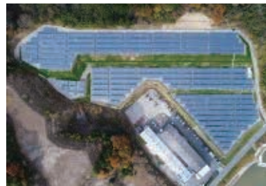
たつのメガソーラー発電所
