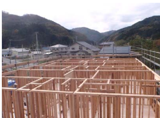
岩手県気仙郡住田町の賃貸アパート（写真撮影時は工事中） 構造材の58.6%が国産材を使用し、そのうちの50% 以上は気仙スギの縦枠材を使用しました。
