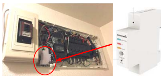
電力センサー設置例(主幹ブレーカーに設置)
