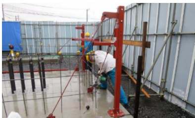
〈アンカーフレームを設置する様子〉
