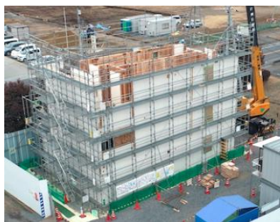
〈建設中の実験棟 3階建て・全6戸〉
