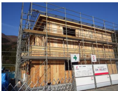
〈CLT造の賃貸住宅1号棟建築の様子(3月撮影)〉
