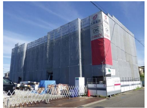
再エネ100%で建設した建物(北名古屋市)
