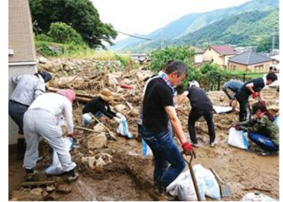
被災した建物の復旧活動の様子
