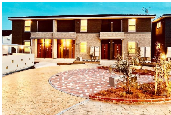
【金賞】 設計:前橋支店 施工:高崎工事部
