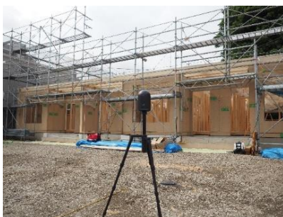
3Dスキャナで施工現場を読み込み
