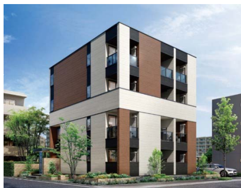
CLT工法を採用した賃貸集合住宅「Forterb(フォルターブ)」
