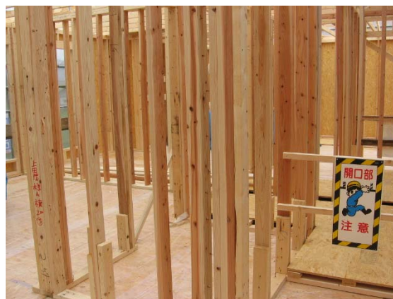
国産スギを導入した賃貸住宅の1号棟を建設している様子
