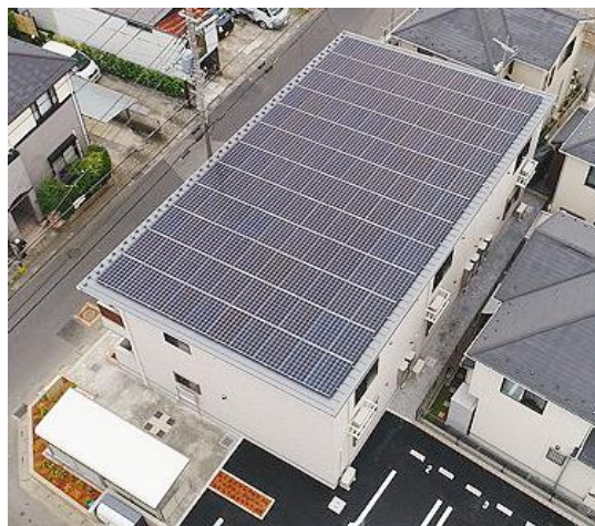
屋根に設置された太陽光発電システム
