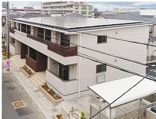
LCCM賃貸集合住宅外観
