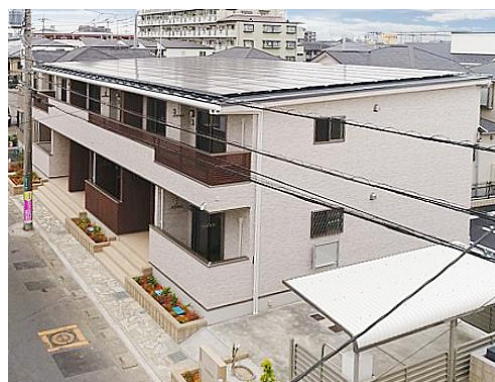
LCCM賃貸集合住宅外観
