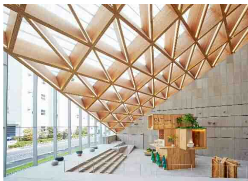
ROOFLAG賃貸住宅未来展示場 CLT(直行集成板)を採用した1階アトリウム
