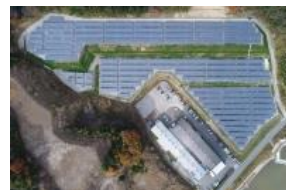
たつのメガソーラー発電所
