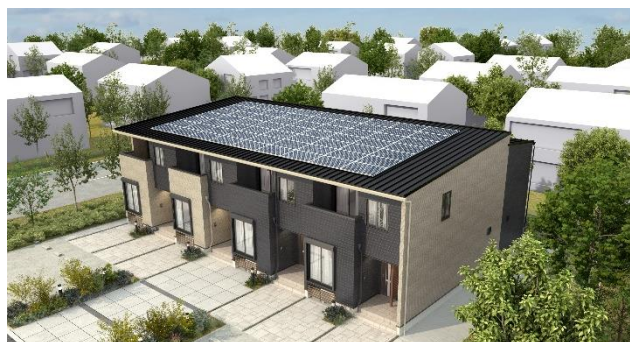
段違い屋根を標準採用し、太陽電池の搭載量を確保
