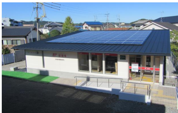
太陽光発電設備を備え、屋根にCLTを使用した 宗像東郷郵便局 外観(福岡県宗像市)
